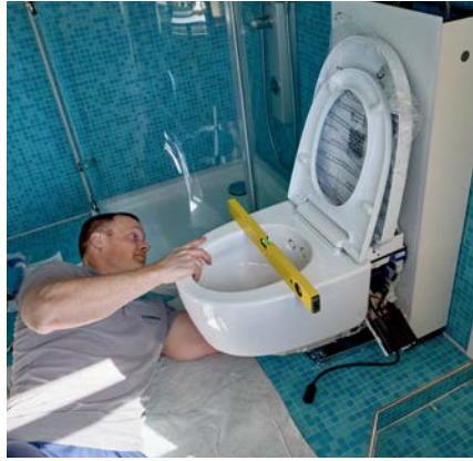
↑ Kusursuz bir montaj için hassas ölçüm büyük önem taşıyor.
