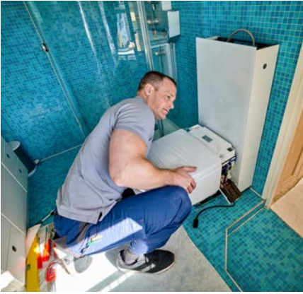
↑ Son aşamada AquaClean Mera Akıllı Klozet, Monolith modülü üzerine monte ediliyor.
