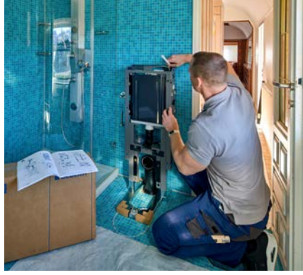
↑ Ardından Monolith modülünün montajına, rezervuar dâhil iç bileşenlerin kurulumu ile başlanıyor.
